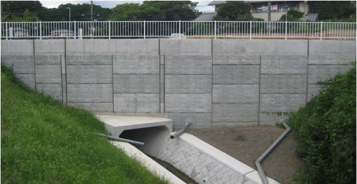
埼玉県飯能市内での補強土壁盛土材の施工事例／スーパーテールアルメGS工法／2015/06
