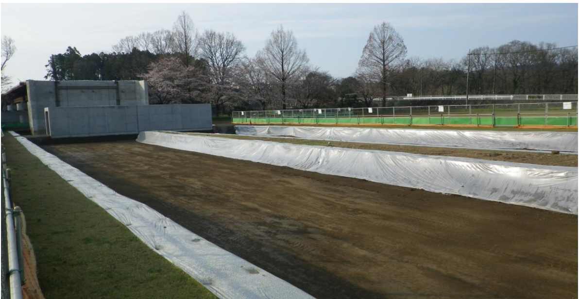
埼玉県日高市内での置換工の施工事例／道路土工／2016/03
