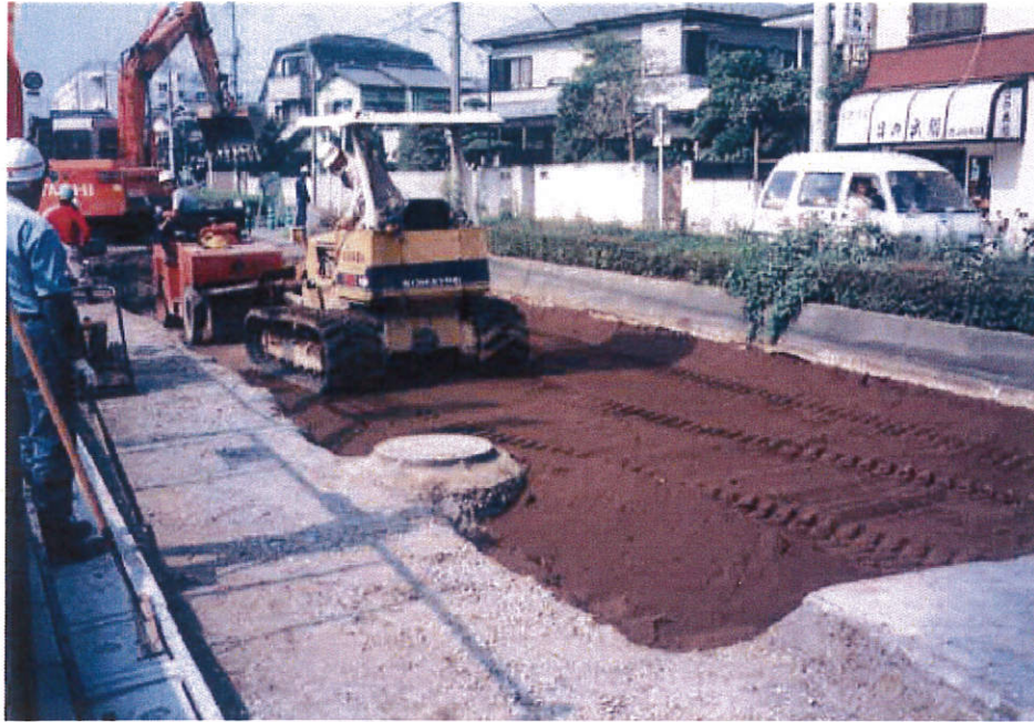
改良土敷均し状況
