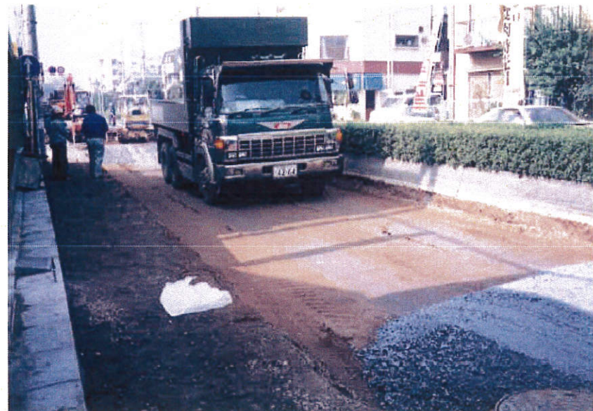
改良土転圧完了
