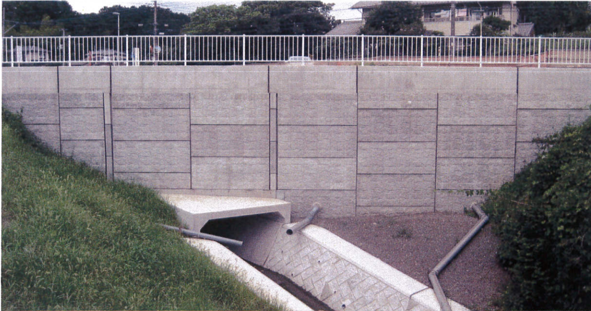
埼玉県内での補強土壁盛土材の事例(2015/6)
